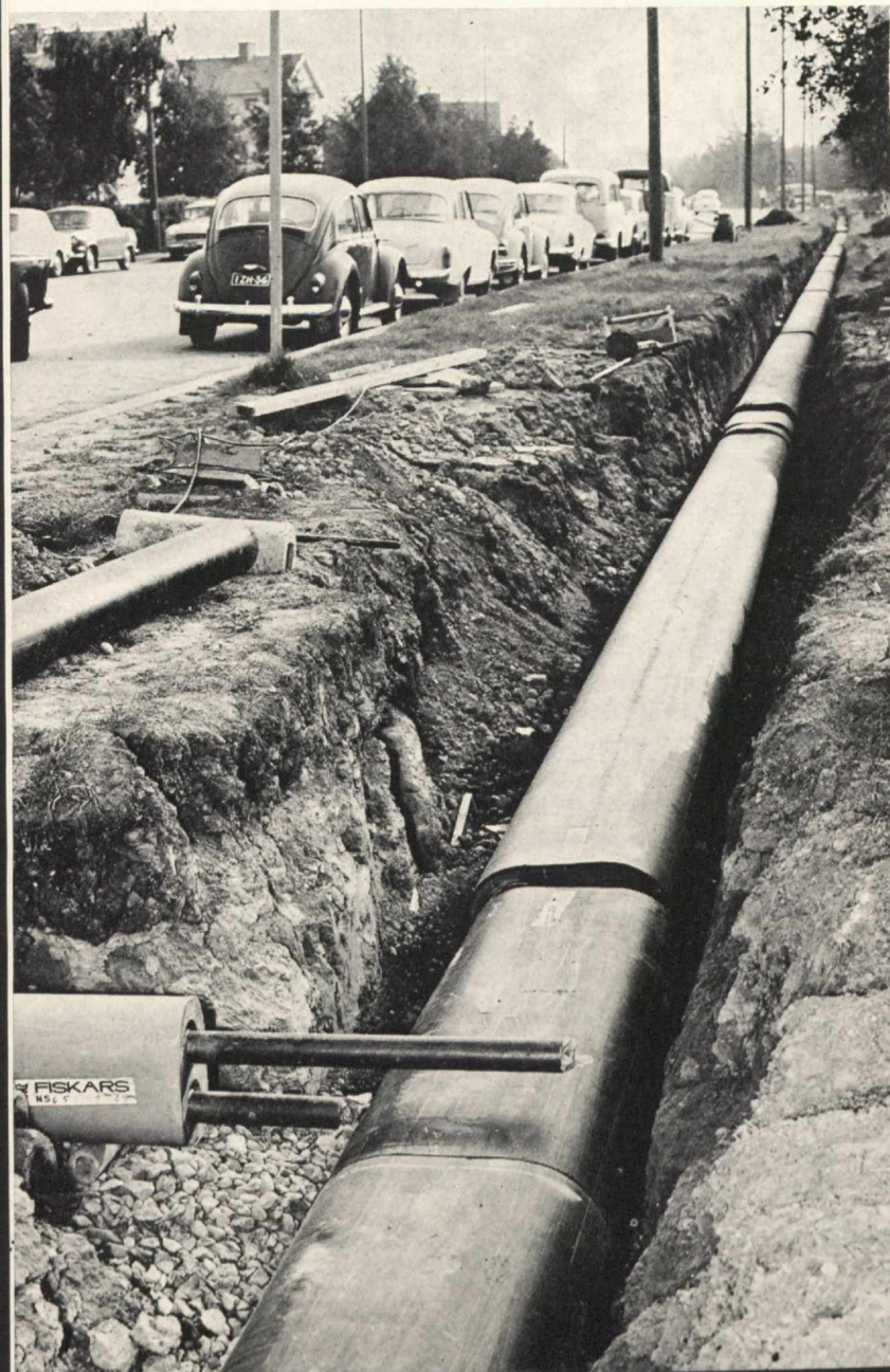
Lasikuituvahvisteisia putkieristyslementtejä, Tammi- saaren Muovitehdas.
