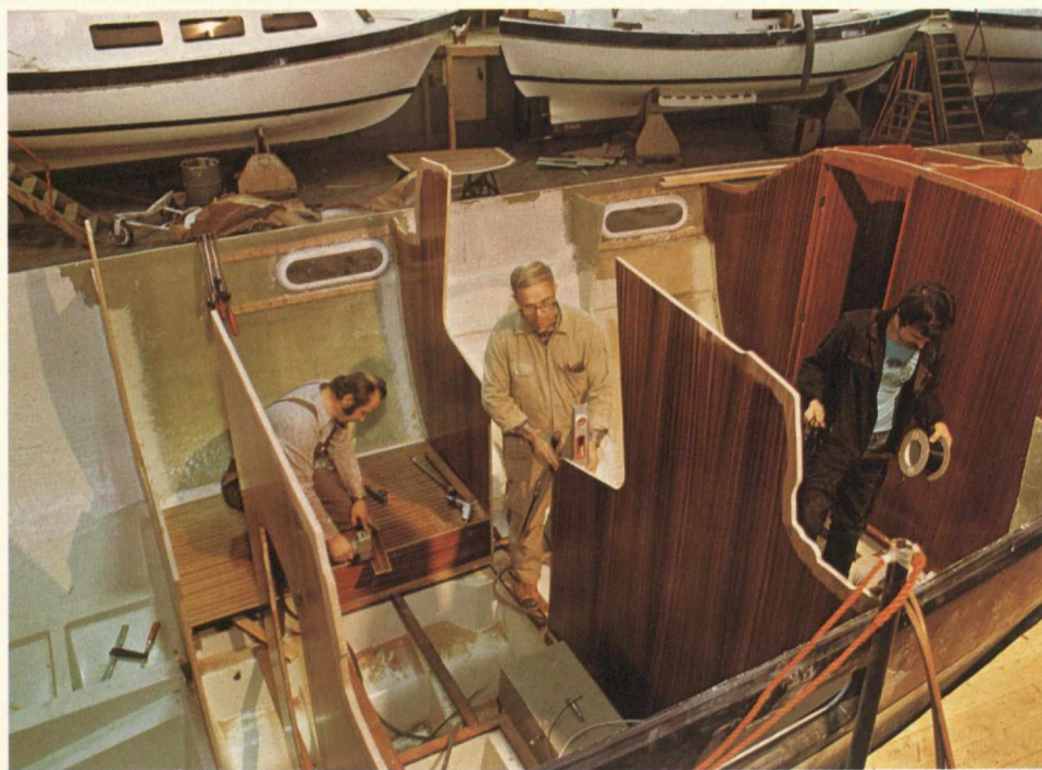
Finnsailer 38 rakenteilla Turun Veneveistämöllä. Henkilöt (vas.) varustelupuusepäät Keijo Sirkkiä ja Heikki Inkinen sekä sähköasentaja Heikki Ylijoki.
