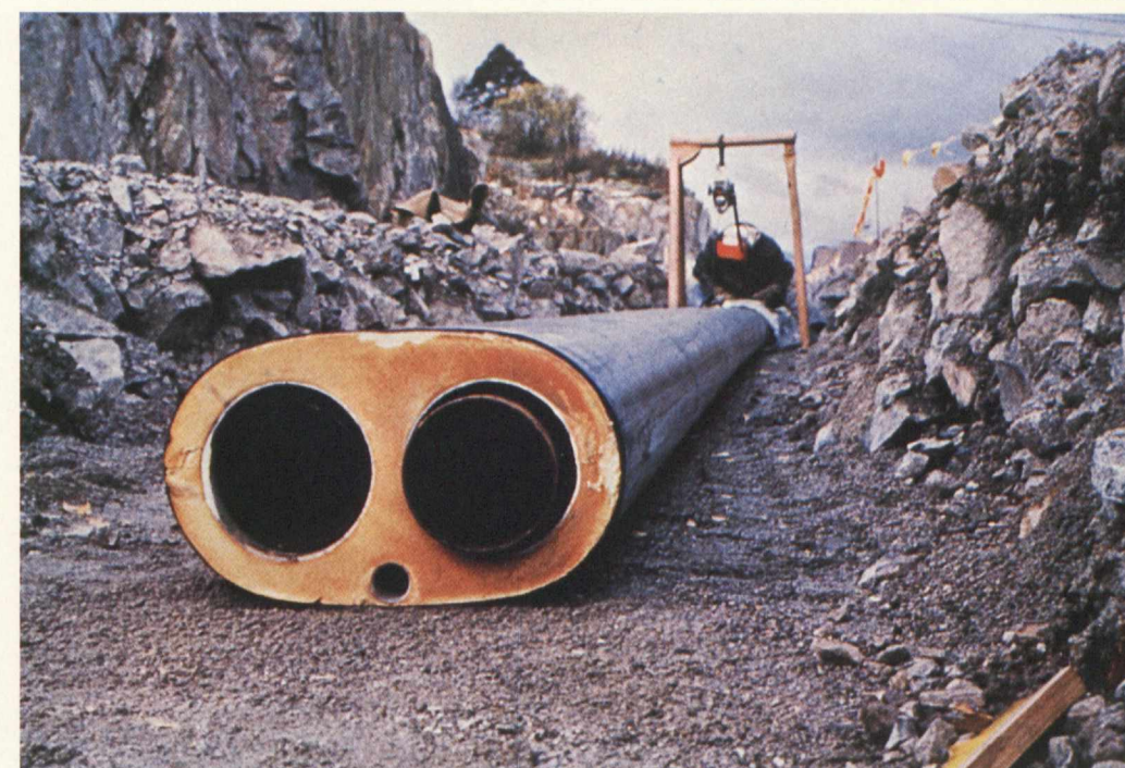
Helsingin kaupunki käyttää Fiskatherm eristysjärjestelmää kaukolämpöjärjestelmän rakentamiseen. Kuvassa asennetaan paikalleen lämpö- eristysputkea Pasilassa. Lämpö tulee Hanasaaren voimalasta.
