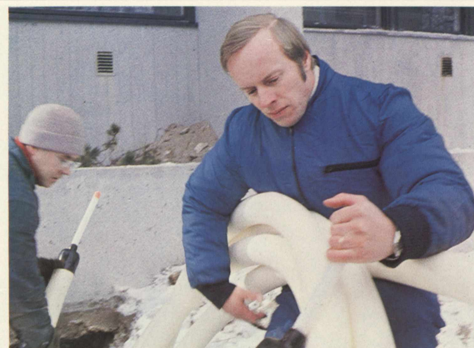
Fiskarsin Minitherm-putki-järjestelmä on herättänyt suurta huomiota rakennus-alalla. Myynti-insinööri Krister Gustafsson avustaa Minitherm-lämmitys- ja lämmönsäätöjärjestelmän asennuksessa yhteisen lämpökeskuksen omaavalla rivitaloalueella.
