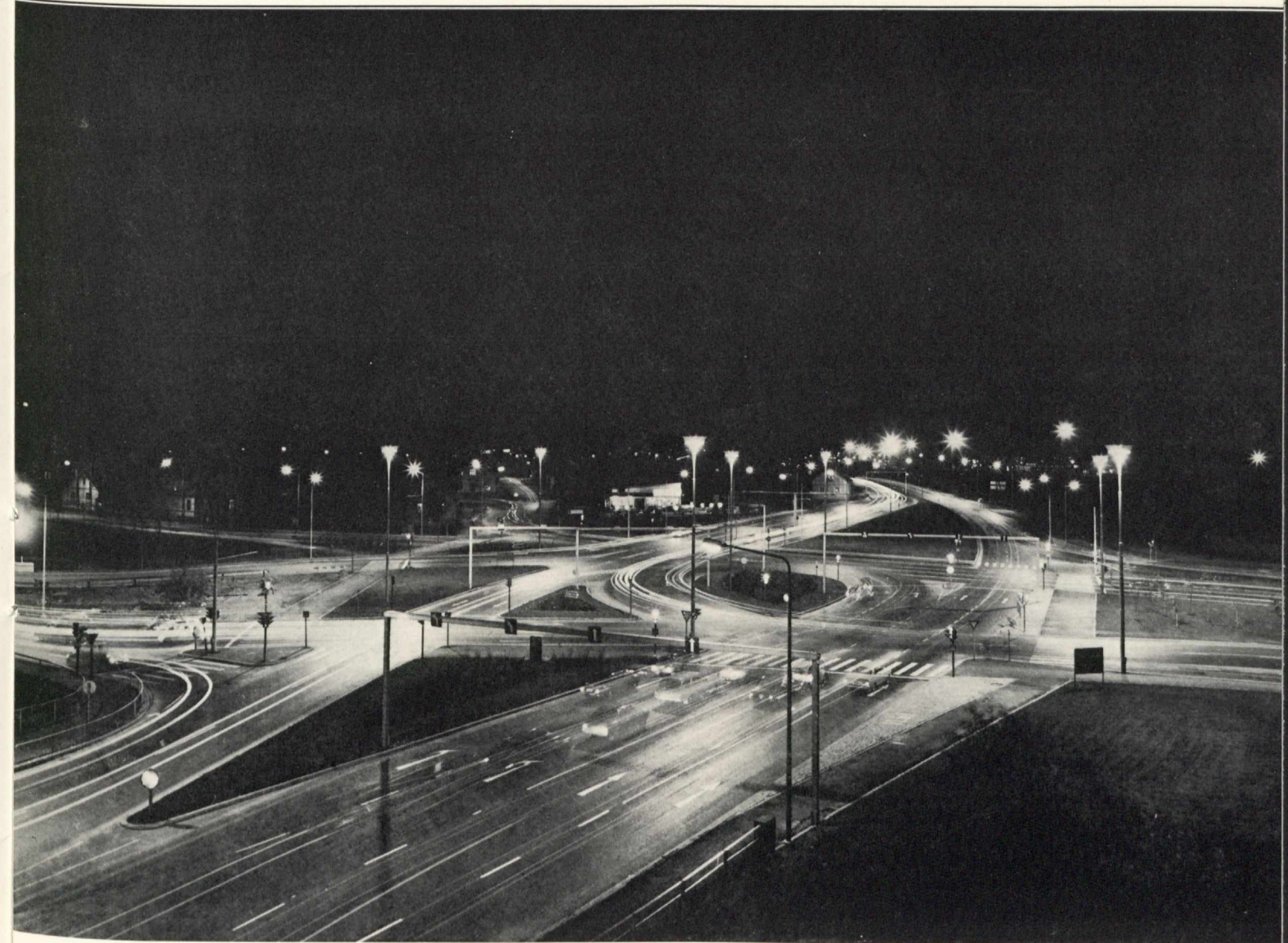
Fiskars trafikljus i Viinikka-korsningen i Tammerfors, där fjärr- och närtrafik möts. Trafiken dirigeras med 64 signalenheter.
