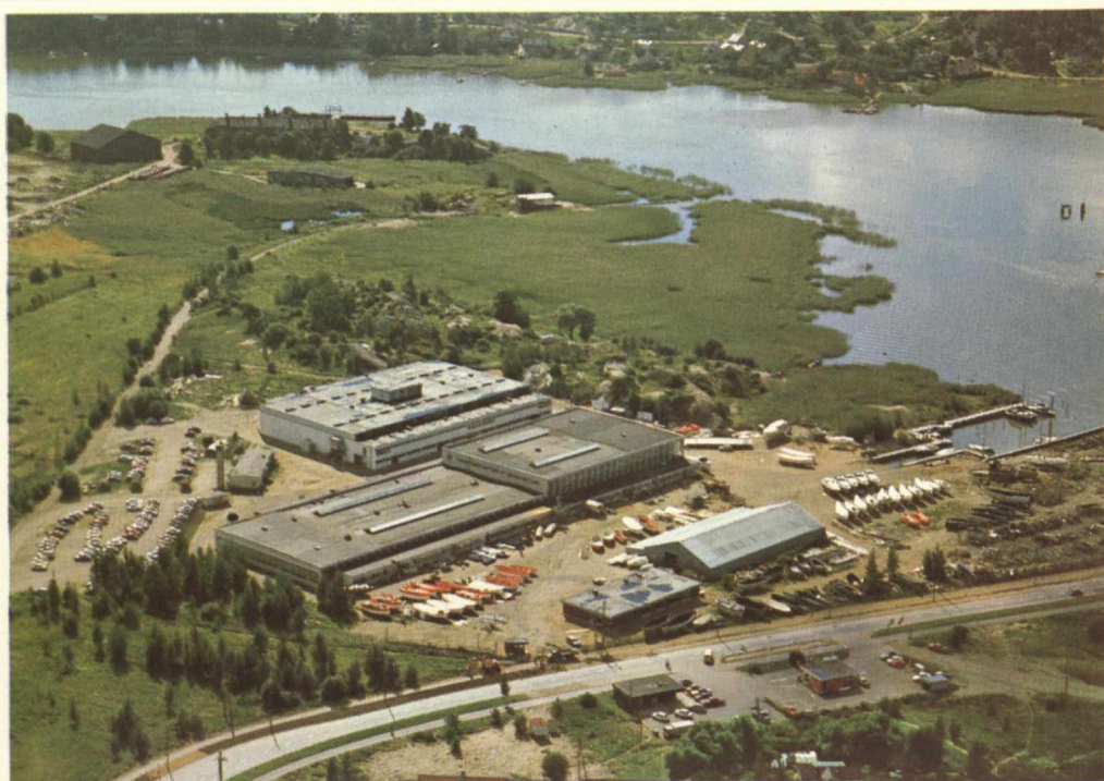
Åbo Båtvarf, vars byggnads- volym efter den senaste utvidgningen är 75 000 m 3
