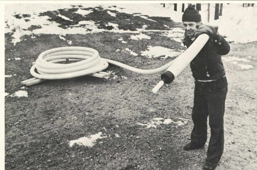
Osmo Leskinen demonstrerar Plastfabrikens nya PEX-rorisoleringsystem, som möjliggör avsevärt billigare värme-kanallösningar speciellt för småhusområden, egna hemshus och växthus.
