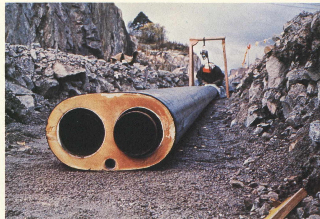
Helsingfors stad bygger ut sitt fjärrvärmenät med Fiskatherm isoleringssystem. Här lägges ledningen i Fredriksberg. Värmen kommer från Hana-holmens kraftverk.
