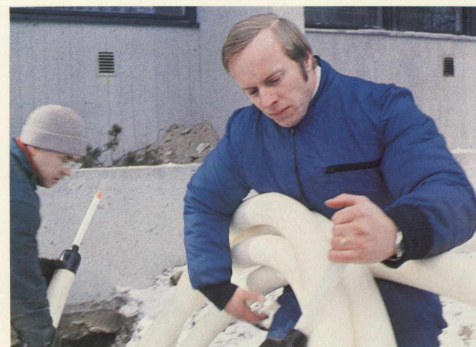
Fiskars Minitherm rörsystem har väckt stor uppmärksamhet inom byggnadsbranschen. Försäljning. Krister Gustafsson hjälper till vid installering av ett Minitherm uppvärmnings- och varmvattensystem på ett radhusområde med gemensam värmecentral.
