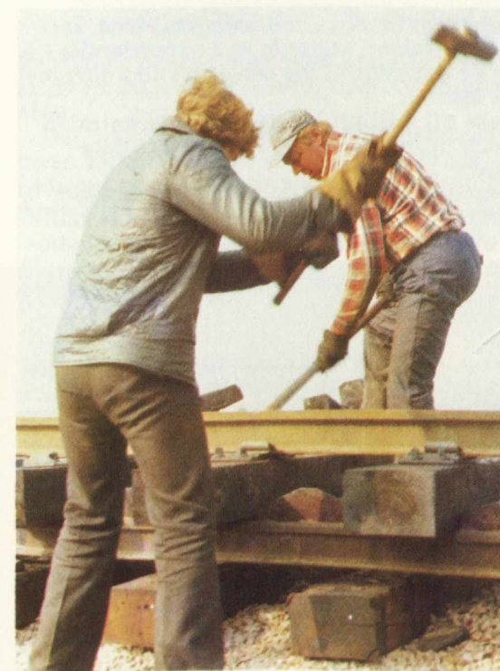
Vid läggning av järnvägsräls används monteringsprodukter från Fiskars fabriker i Inha.
