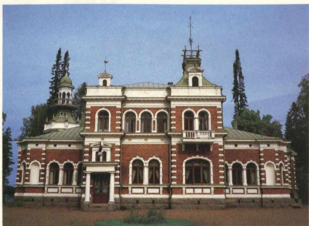
Disponentens byggnad i Inha, byggd 1898, hör till de bruksmiljöer bolaget skyddar.
